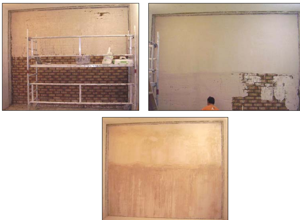
Fotografías 4, 5 y 6 Proceso de enyesado de la pared
